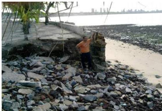
**Figura 07** – Praça de Iemanjá (praia do Cabo Branco) parcialmente destruída pela ação das ondas.
