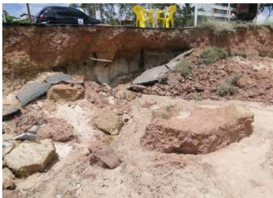
**Figura 05** – Remobilização de blocos, oriundos de aterros localizados na Praia do Seixas, ocasionadas pela erosão costeira.
