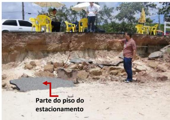
**Figura 04** – Destrução de parte do piso do estacionamento localizado na Praia do Seixas, ocasionada pela erosão costeira.
