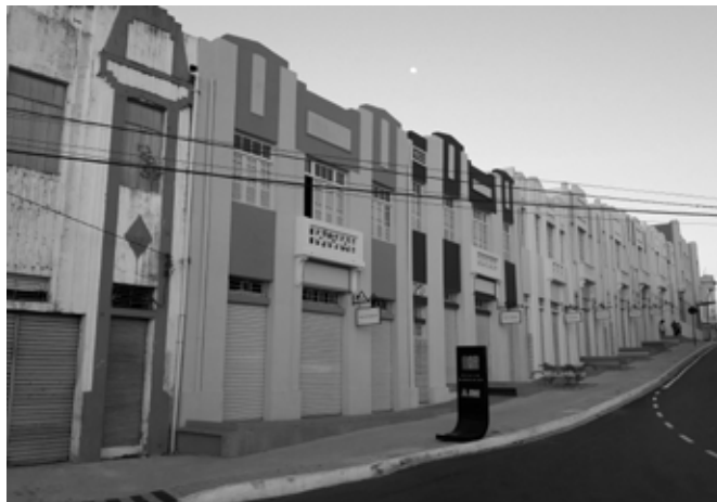
Figura 9 – Foto da obra concluída a partir da rua.
