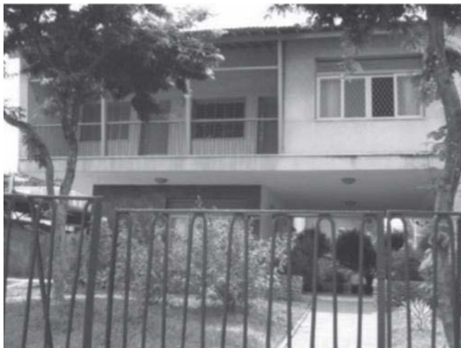
Figura 01: Casas Modernistas de Augusto Reynaldo, ainda em bom estado de conservação
