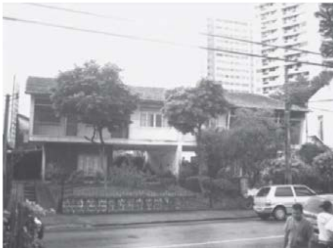
Figura 02: Imóvel nº 625, ainda em bom estado de conservação
