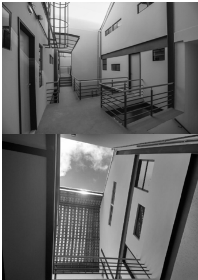
Figuras 10 e 11 – Fotos da obra concluída - passarelas internas e átrio.
