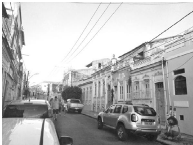
Fig. 3: Centro Histórico de Salvador Fonte: Arquivo pessoal dos autores. Fig. 4 e 5 : Fachada e imagem do interior projetado e adaptado para habitação cuja fachada foi restaurada pela UNESCO.
