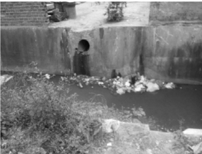
Figura 05: Córrego poluído sem infraestrutura
