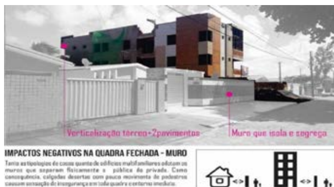
Figura 10: Muro e segregação público x privado.
