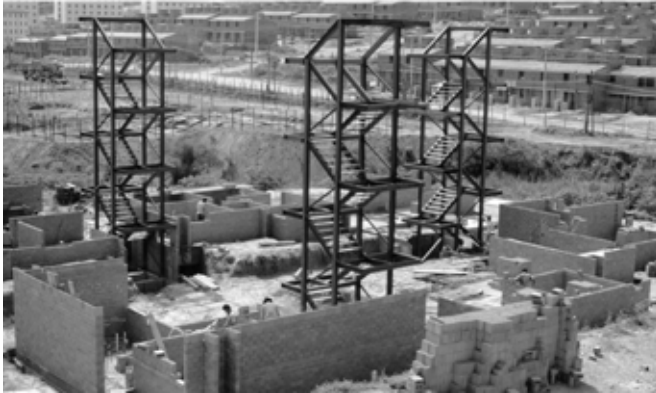
Figura 02: Imagem das obras do Mutirão da Jata, em São Paulo. 1992.
