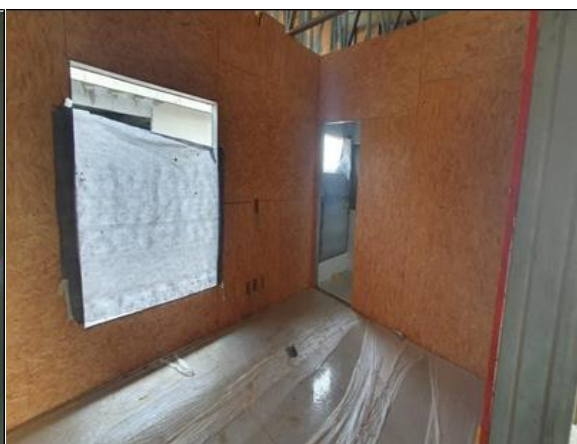
Canteiro de obras (Quarto 2)
