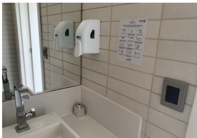
Figura 9 – Área do sanitário.
