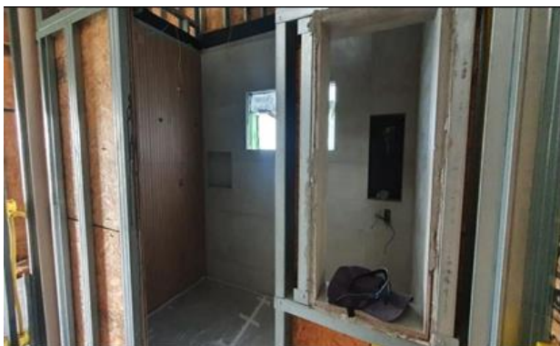
Canteiro de obras (Banheiro Suíte)
