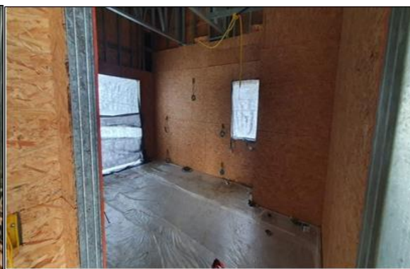
Canteiro de obras (Quarto)
