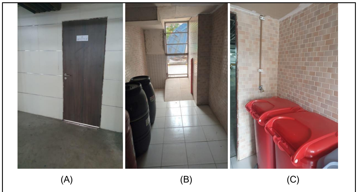
Figura 6. Abrigo externo de RSS. Identificação da porta de abrigo dos RSS (A); Estrutura interna do abrigo de RSS (B). Ponto de saída de água (C)
