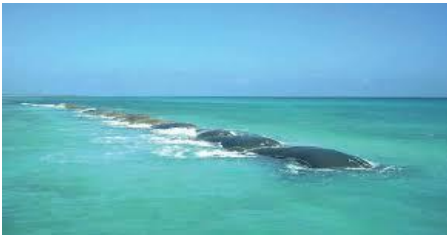
Figura 11: Utilização de Geotubos com função de quebra-mar, buscando dissipar a energia de ondas incidentes a praia, um dos fenômenos que promove a erosão marinha.
