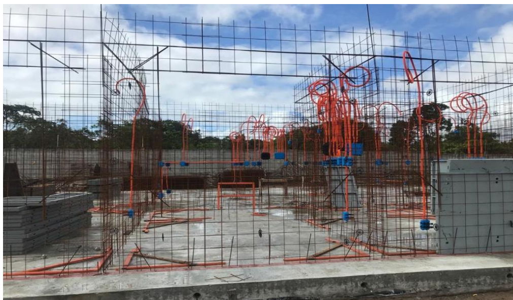
Figura 20: Instalações elétricas
