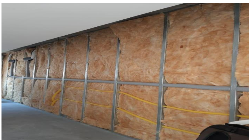
Figura 1- Instalação de uma parede em drywall com aplicação da lã de vidro.
