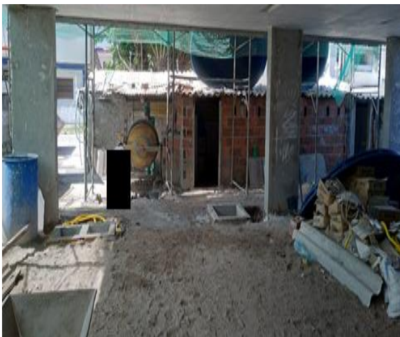
Figura 17 – Área operacional do canteiro C
