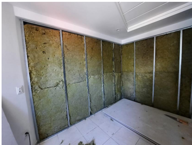
Figura 9 - Aplicação da lã de rocha na parede de drywall.
