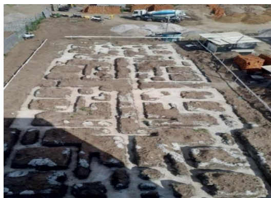
Figura 2 – Vista superior do canteiro de obras
