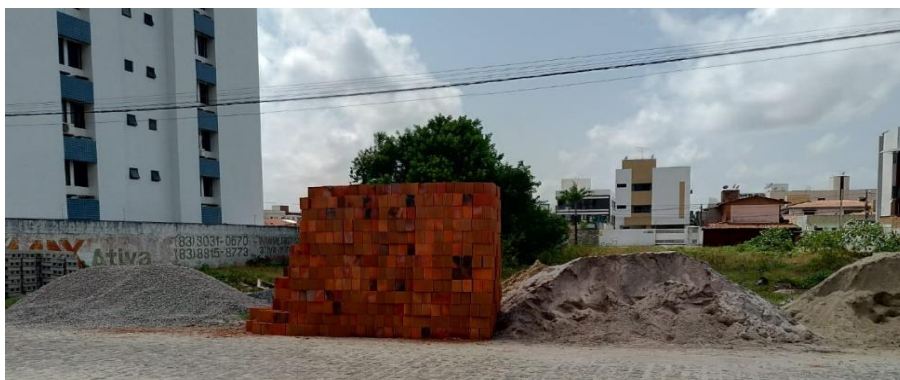
Figura 9 – Materiais de construção na calçada em frente a obra
