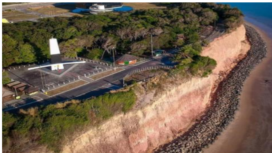
Figura 6: Obras de enrocamento de rochas cristalinas depositadas no sopé da Falésia para o combate a erosão marinha. Destaque para o farol do Cabo Branco (parte esquerda da foto) um dos pontos turísticos mais visitados.
