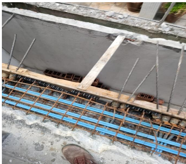
Figura 13 – Instalações das ancoragens e adaptadores
