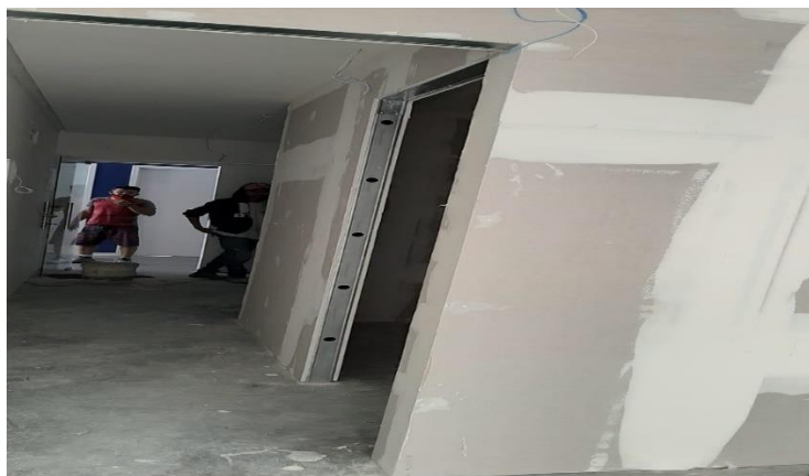
Figura 23 - Parede em drywall com vão de porta.
