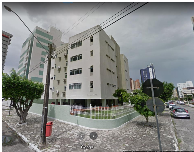
Figura 10 – Foto em solo da fachada Norte e Oeste do edifício.
