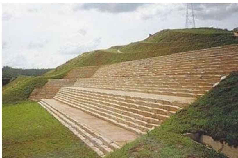
Figura 13: Utilização de Bolsacreto na Rodovia Ayrton Senna (SP), buscando estabilizar talude
