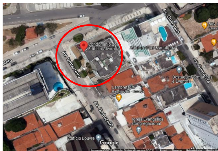
Figura 9 – Localização do edifício vista de cima.
