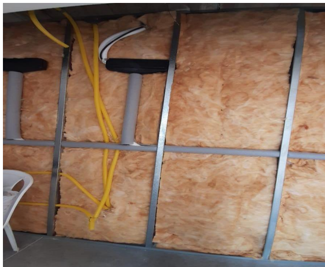
Figura 17 - Parede em drywall com isolamento acústico sendo instalada.
