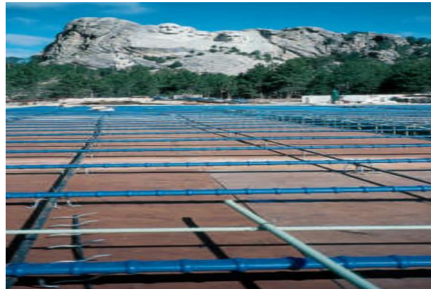
Figura 3 – Laje com protensão aderente
