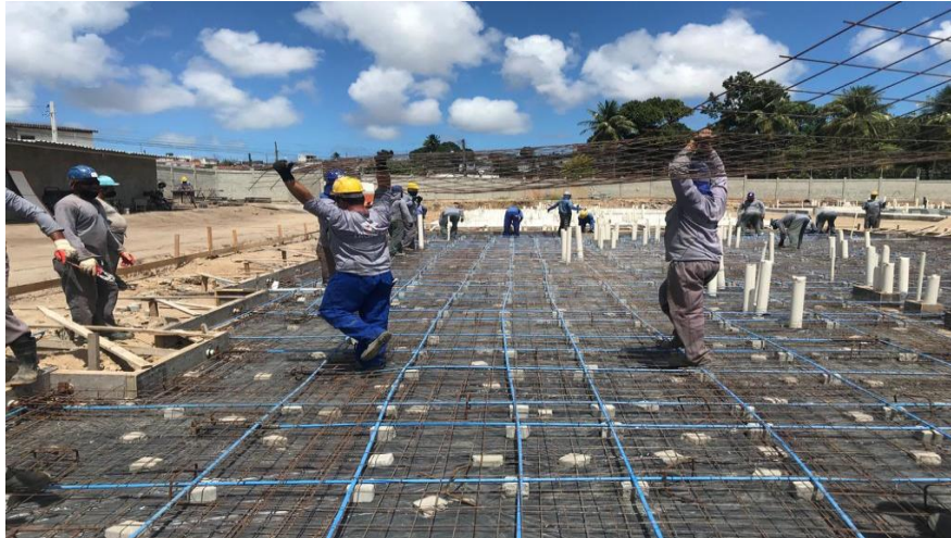
Figura 14: Radier protendido sendo executado
