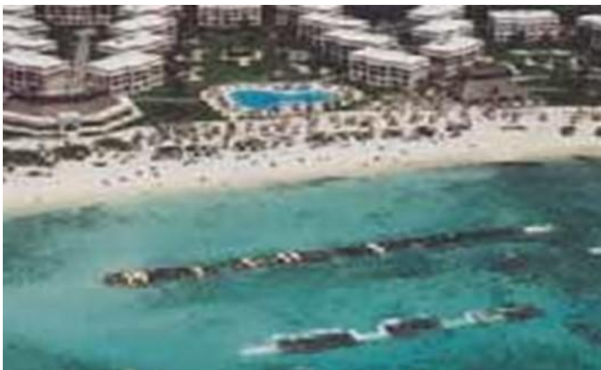
Figura 12: Utilização de quebra-mar colocando geotubo em Cancún, México.
