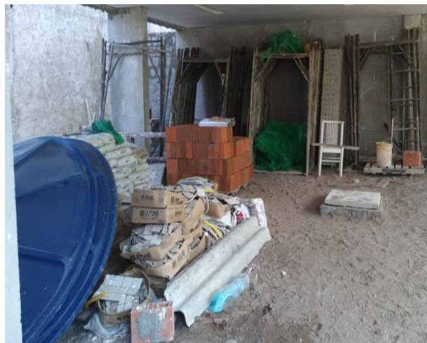
Figura 18 – Local de armazenamento
