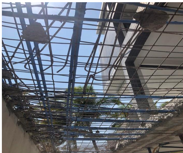
Figura 11 – Laje Parcialmente demolida
