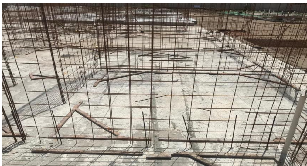
Figura 19: Esquadros instalados
