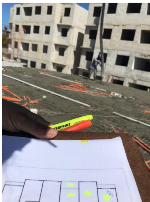
Figura 25: Mapeamento do concreto
