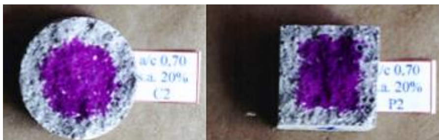
Figura 3 – Carbonatação do concreto constatada em corpos de prova.
