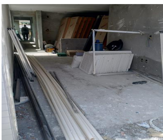
Figura 20 – Armazenamento de materiais
