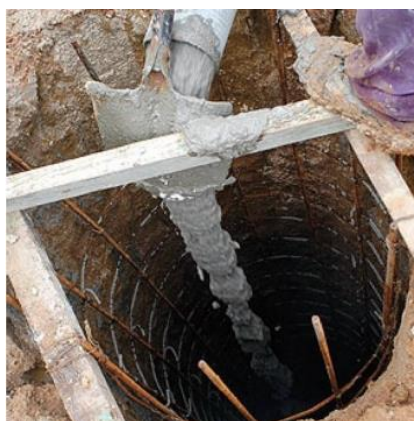
Figura 1 - Concretagem de uma estaca escavada.
