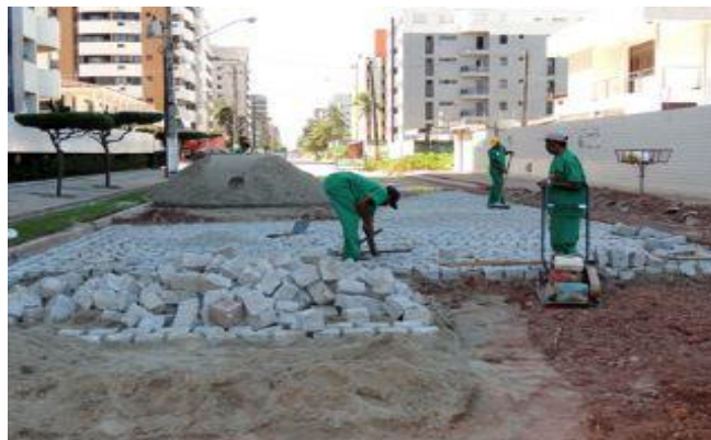
Figura 7 – Execução da sub-base (colchão de areia).
