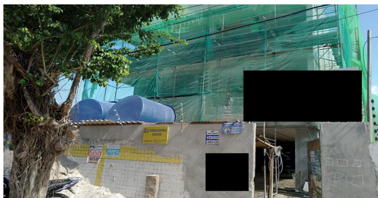
Figura 16 – Frente do canteiro de obras C
