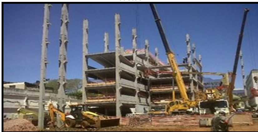
Figura 6. Construção pré-moldada vantagens dos elementos pré-fabricados de concreto, dado o uso de elementos que garantem mais agilidade no processo de construção com eficiência e redução de custos.
