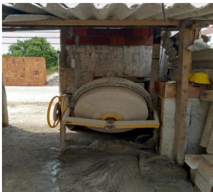
Figura 10 – Local da betoneira
