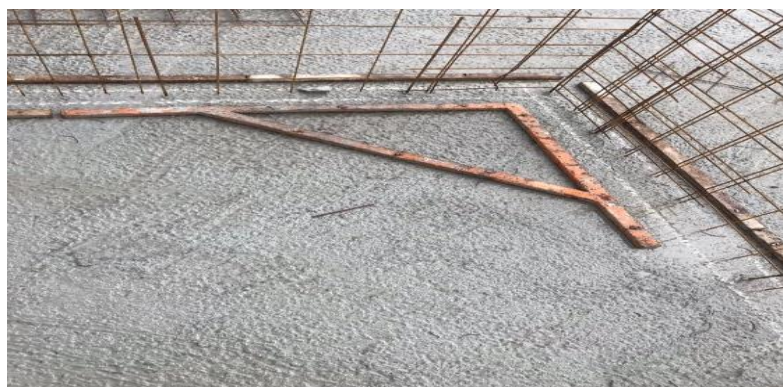
Figura 2: Gabarito montado em piso
