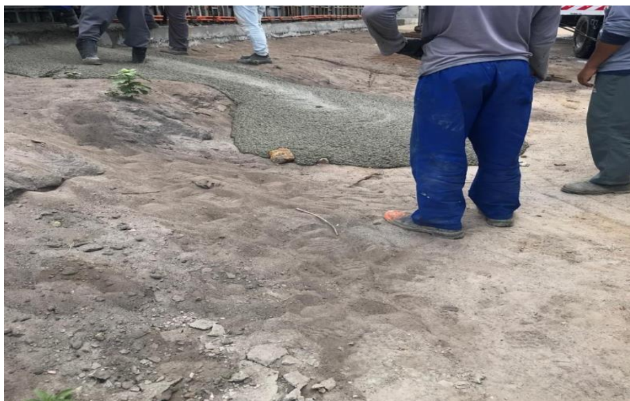
Figura 28: Concreto derramado com a soltura das travas
