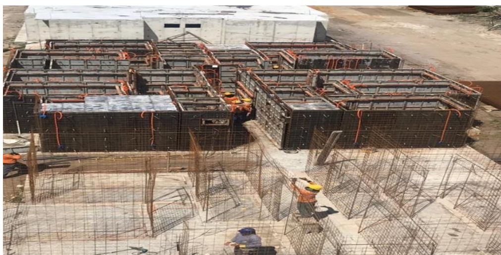
Figura 3: Montagem da armação em andamento
