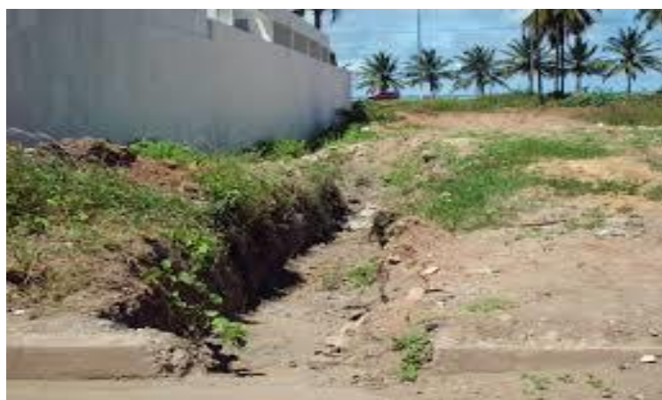
Figura 5 – Escavação mecanizada de valas
