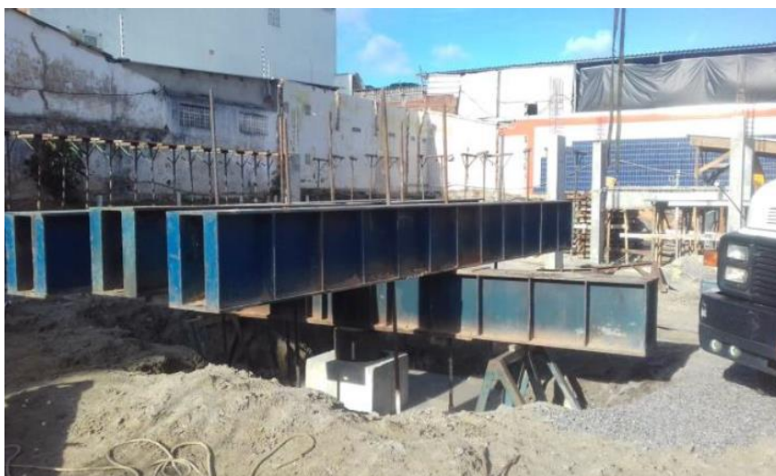
Figura 5: Montagem do ensaio da estaca 31 do Pilar 9.
