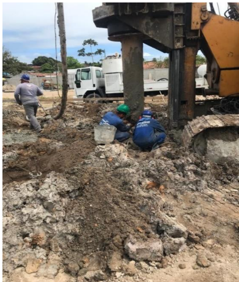
Figura 15: Execução das estacas hélice
