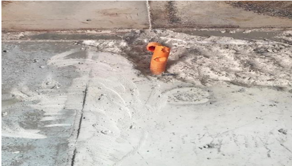
Figura 27: Eletroduto rompido
