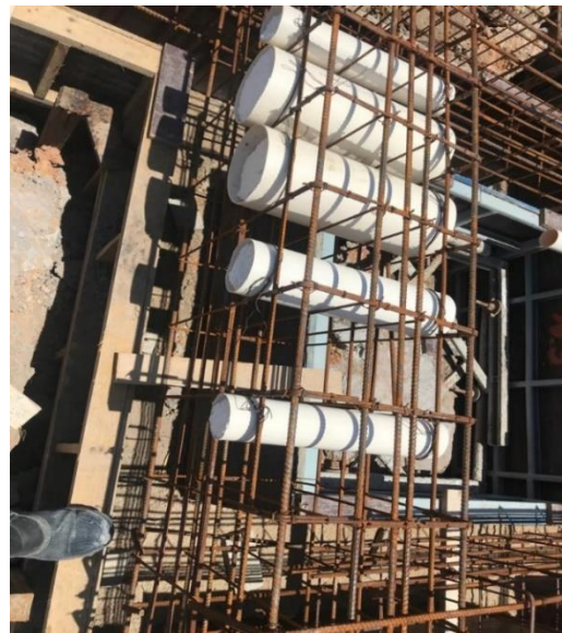
Figura 16: Passagens de tubulações das vigas
