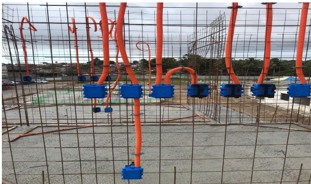
Figura 4: Passagens elétricas das paredes
