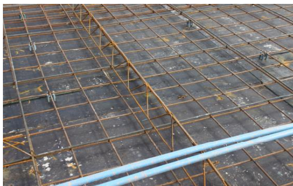
Figura 6 – Sistemas de apoio para armadura convencional “cocadas” e treliças para apoiar as cordoalhas
