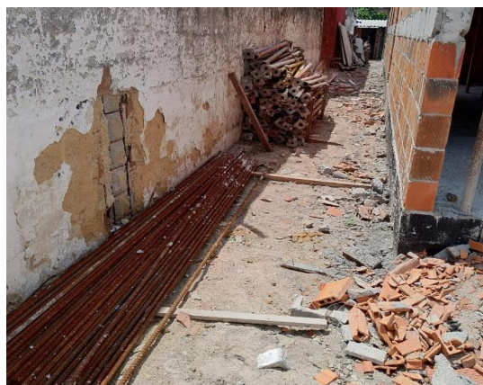
Figura 13 – Ferragens e escoras
