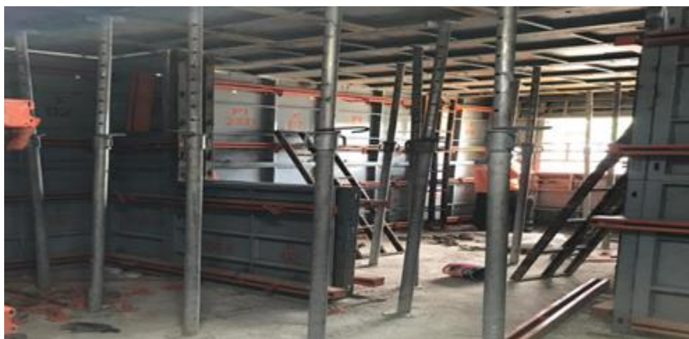
Figura 8: Estrutura escorada
