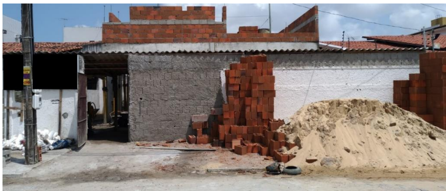
Figura 8 – Frente do canteiro de obras B
