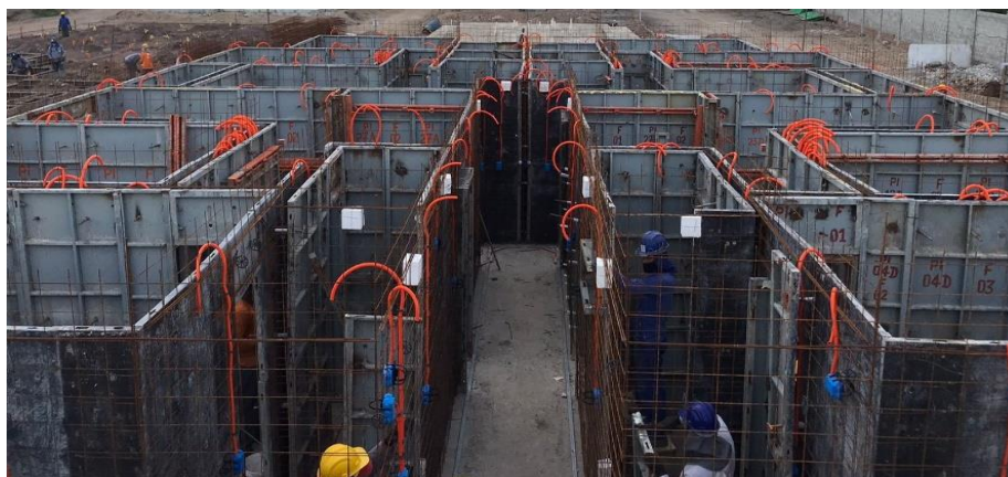
Figura 21: instalação das formas em execução
