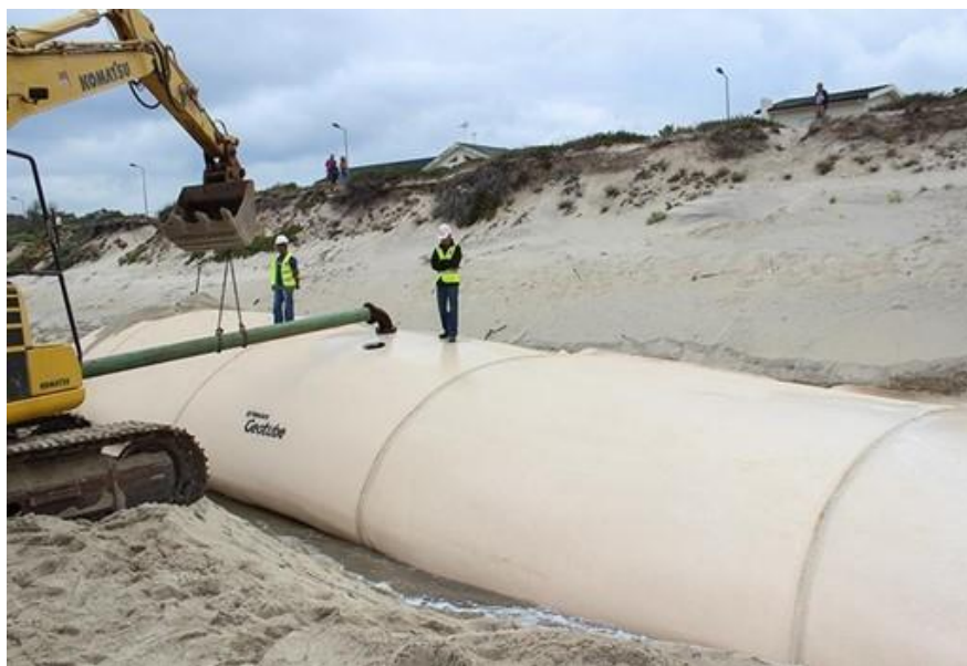
Figura 10: Geotubo sobre faixa de areia na praia de Moledo, em Caminha, Portugal.
