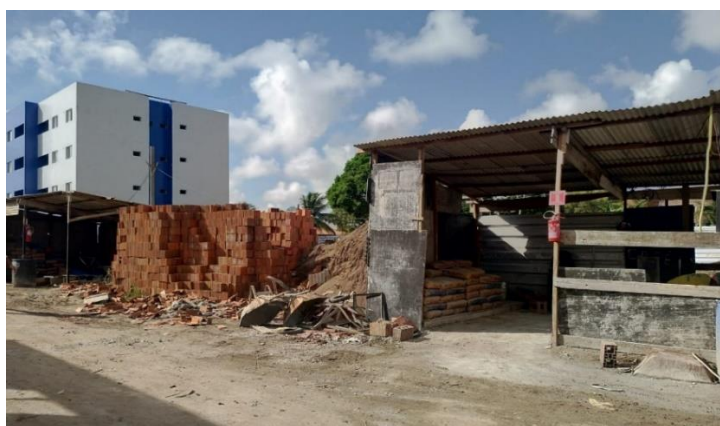
Figura 3 – Local da betoneira, depósito de cimento e bloco cerâmico
