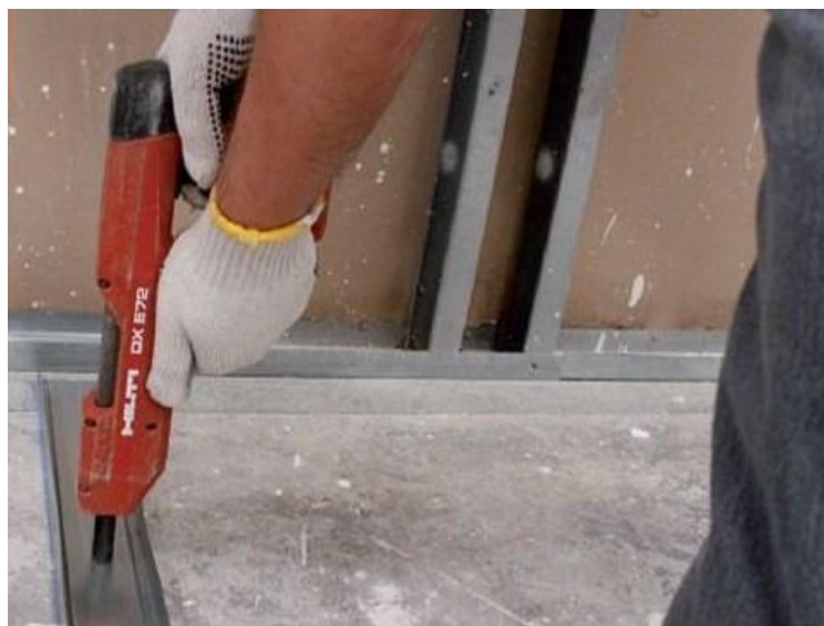
Figura 13 - Fixação das guias.
