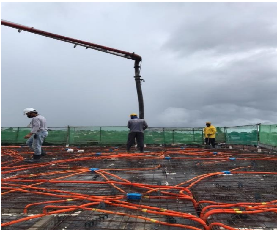
Figura 9: Concretagem sendo executada
