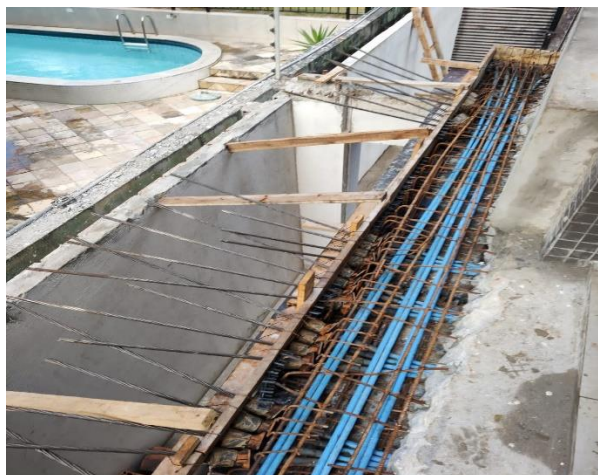
Figura 14 – Parte da laje demolida pronta para concretagem
