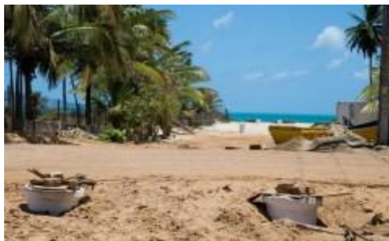
Figura 6 – Realização da drenagem urbana das águas pluviais.
