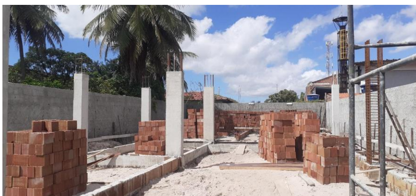
Figura 1.7 – Fase de elevação da estrutura do empreendimento.
