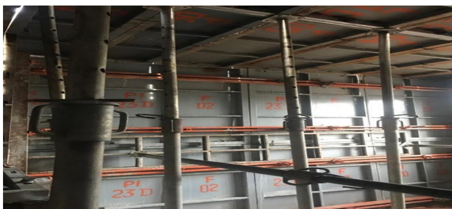
Figura 23: Escoramento e travamento
