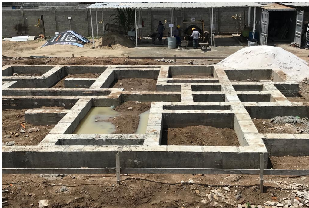
Figura 17: Vigas baldrames executadas
