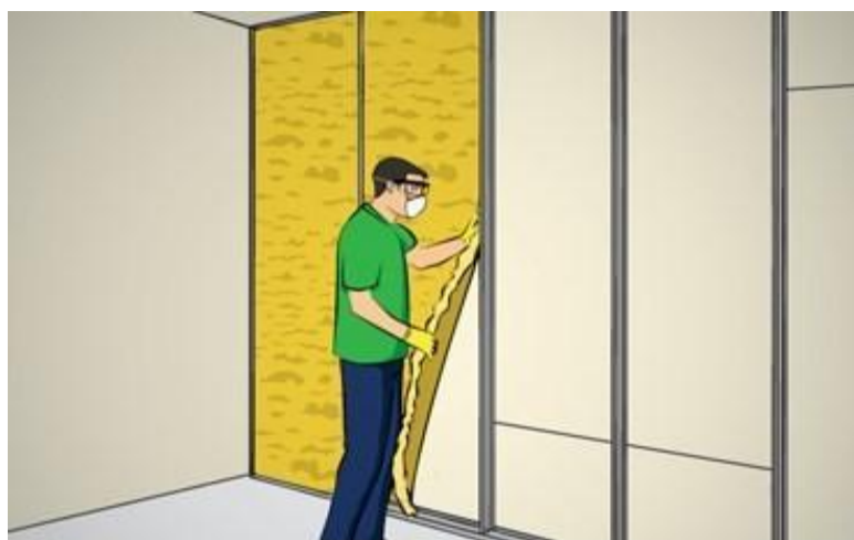
Figura 15 - Colocação de isolamento.
