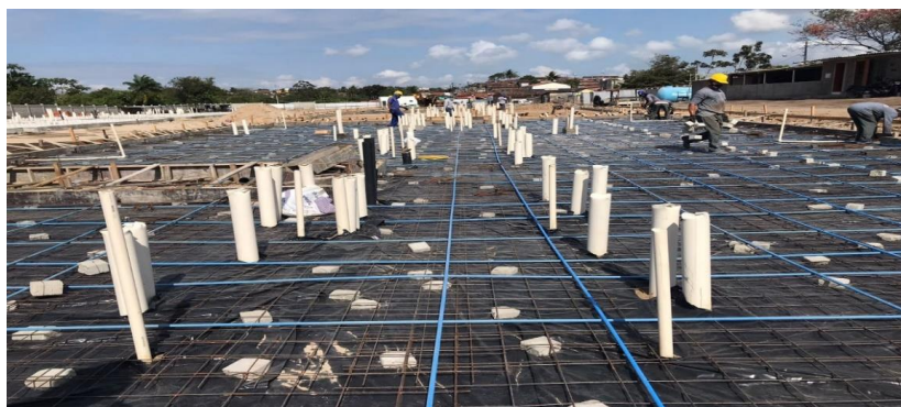
Figura 1: Fundação em radier em andamento
