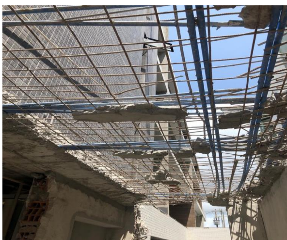
Figura 12 – Laje Parcialmente demolida
