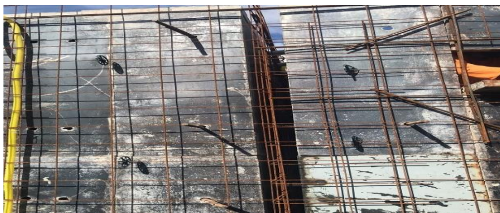
Figura 7: Montagem de formas em andamento
