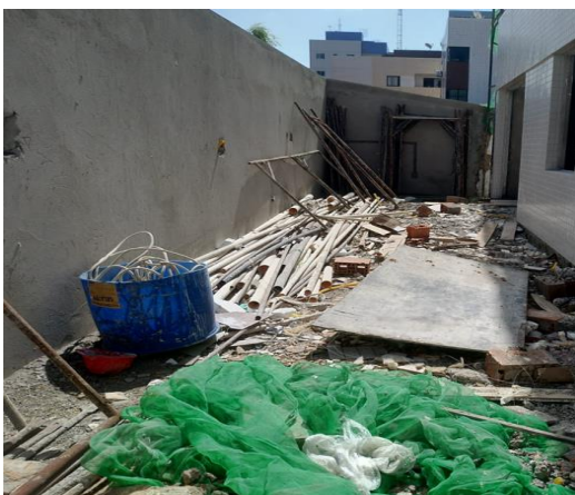
Figura 19 – Andaimes e sobras de materiais
