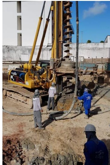
Figura 1 - Execução de uma estaca do tipo hélice contínua
