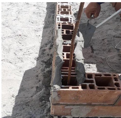
Figura 2.0 – Assentamento do bloco cerâmico com a colher de pedreiro.
