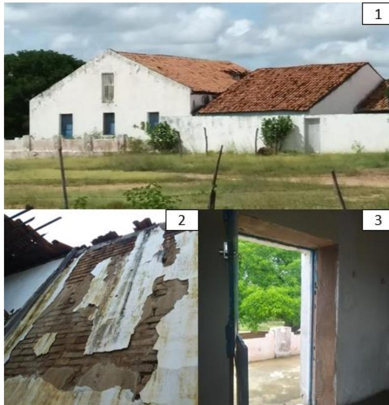
Legenda: 1- Perspectiva externa: sótão que era usado para vigilância; predominância do cheio sobre vazio; jogos de telhado com duas águas em telha canal; 2 – perspectiva interna: a alvenaria sem reboco mostrando a estrutura de tijolos cerâmicos cozidos; 3 - parede com espessura larga e porta com esquadria tipo “blusa e saia”. Fonte: Zuza (2019).
